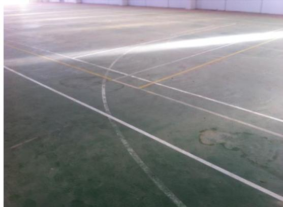
Figura 2 - Pozze d'acqua interno campo da gioco
